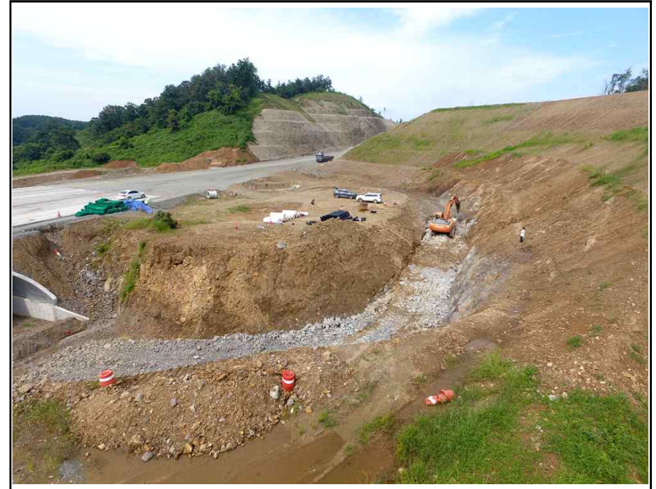
【그림 4】 깎기비탈면 종점부 측면 사진
