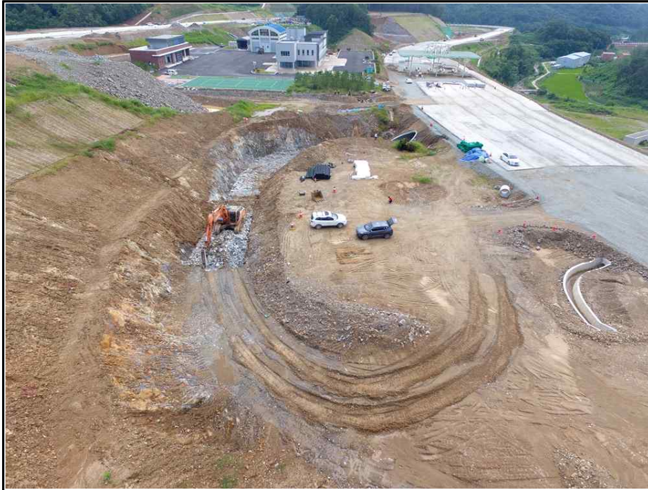
【그림 3】 깎기비탈면 시점부 측면 사진
