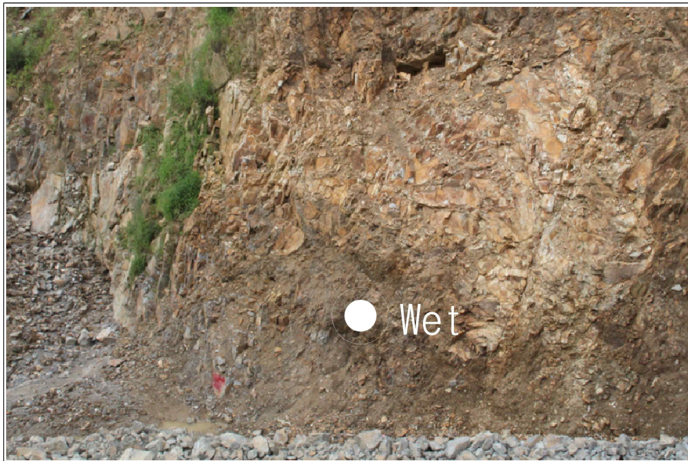
【그림 14】 A 영역 상세사진 (지하수 유출)
